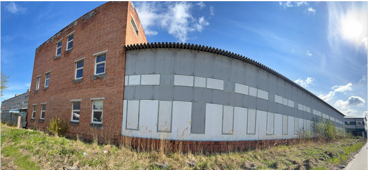
Рис. 6. Панорамный вид оцениваемого объекта
